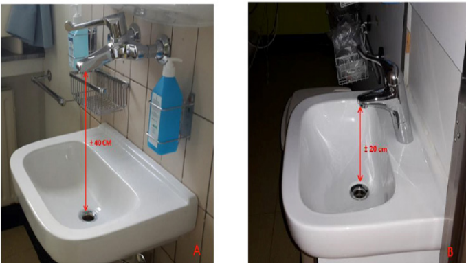
Figuur 3: Kranen in de isolatiekamers (A) en in de standaardkamers (B).
